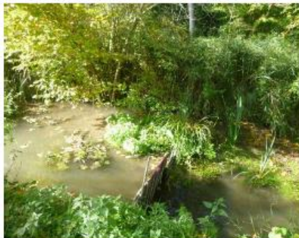
Exemple d'ouvrage simple à faire supprimer par le propriétaire
