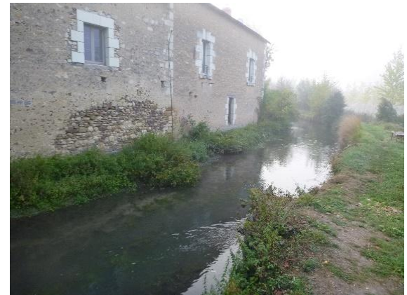
Remise en eau fossé RG
