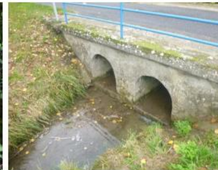
Exemple d'ouvrage à recharger à l'aval
